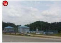
16 Pencawang elektrik yang terletak di Jalan Bukit Besi - Dungun
