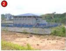
2 Pencawang elektrik yang terletak di jalan masuk ke Universiti Teknologi Mara (UITM) Bukit Besi
